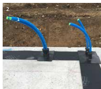
1 Detailansicht einer LASTO®ISOPIPE Rohropolsterung 2 LASTO®ISOPIPE fachgerecht eingebaut
