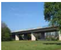
Ohrntalbrücke Öhringen (DE)
