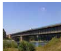
Rheinbrücke Frankenthal (DE)
