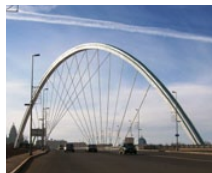
Ramstore Brücke (KZ)
