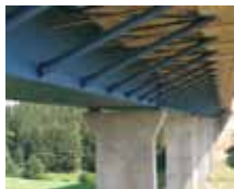
Steinbachtal Brücke (DE)
