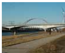
Dintelhaven Brücke (NL)
