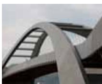
Gleisbogen Brücke (CH)
