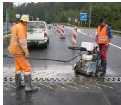
Schneiden der Schlitzte in einem 45° Winkel zur Fahrtrichtung
