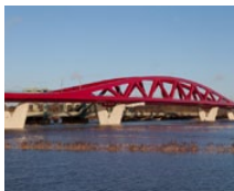
IJssel Brücke (NL)
