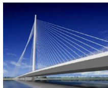
Da Nang Bridge (VN)
