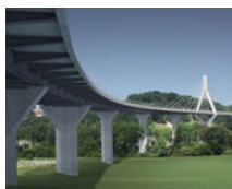
Pont de la Poya (CH)
