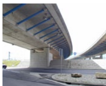
Pont sur le Buron (CH)
