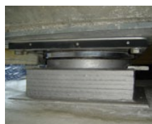
Kalottenlager
