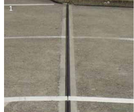
1 Einsatz in Parkdecke
