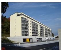
Bâtiment locatif, Givisiez
