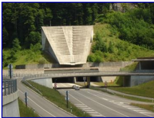
Tunnel Mont Terri St. Versanne
