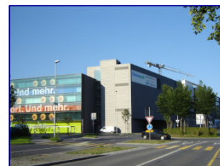
Überbauung Leopold, Sursee
