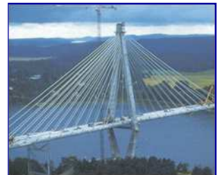
Uddevalå Bridge (Sweden) Pot bearings V_{max} = 15'300 kN
