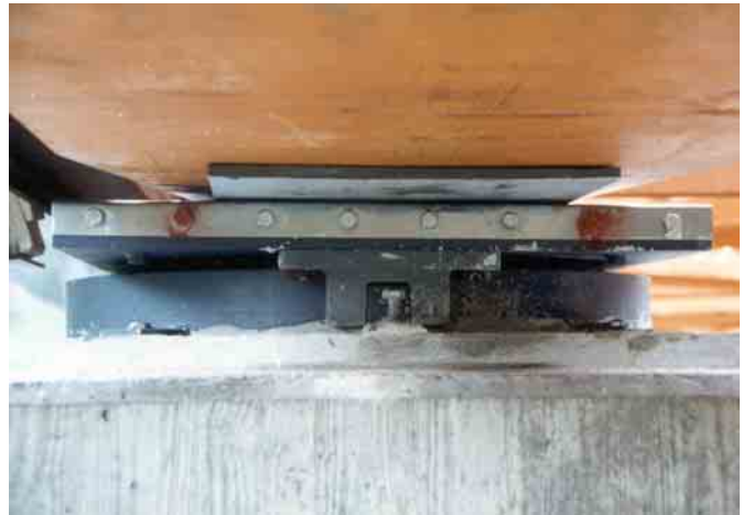
Fig. 5: Elastomerlager als Taktschiebelager
