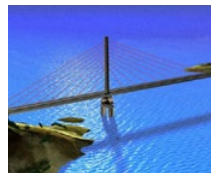
Agin Brücke (TR)
