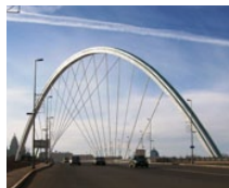
Ramstore Brücke (KZ)
