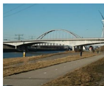
Dintelhaven Brücke (NL)
