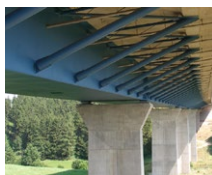
Steinbachtal Brücke (DE)
